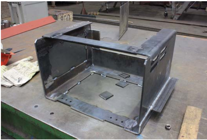
Der Batteriekasten wird am Montageplatz der Lok zusammenschweißt.
