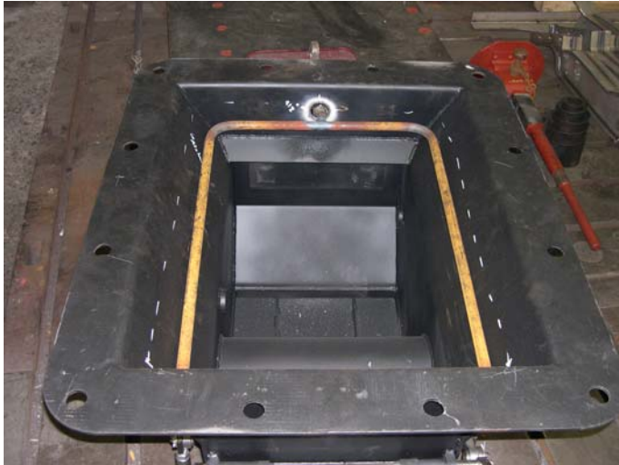
Die Aschkastenspritze wird zum Einbau an den Aschkasten angepasst.
