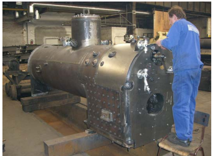
Am Stehkessel wurde mit dem Einkleiden und dem Anbau der Verkleidungsblechhalter begonnen. Die Lagerböcke des Kessels für die Auflagerung im Rahmen sind angeschweißt.
