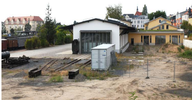
Kurz vor Baubeginn...
